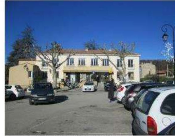
Bâtiment Poste - Trésor public
